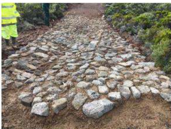
Pavage sur chape béton Foc Foc
